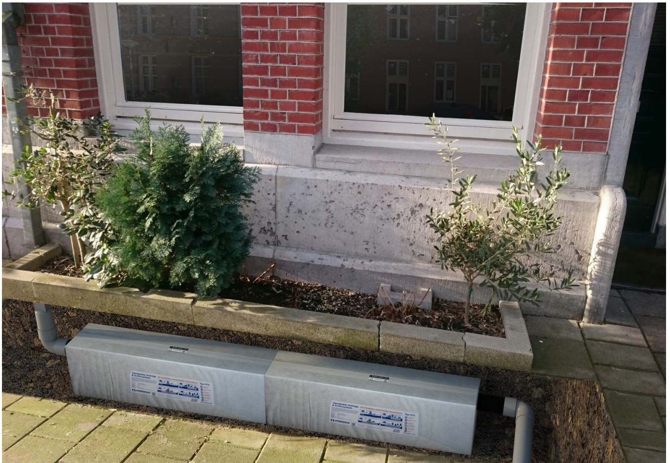
Infiltratieblokken onder een geveltuintje. ©Hydrorock
