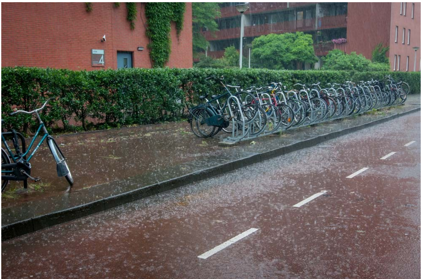
Stoeprand in de van Hallstraat houdt afstromend water tegen. ©Merlijn Michon
