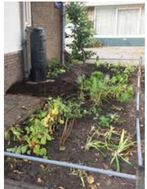
Geuzenveld-de tuin is klaar, de regenpijp is gekoppeld aan de regenton! Waterafvoer in de tuin. Foto R.Aberson
