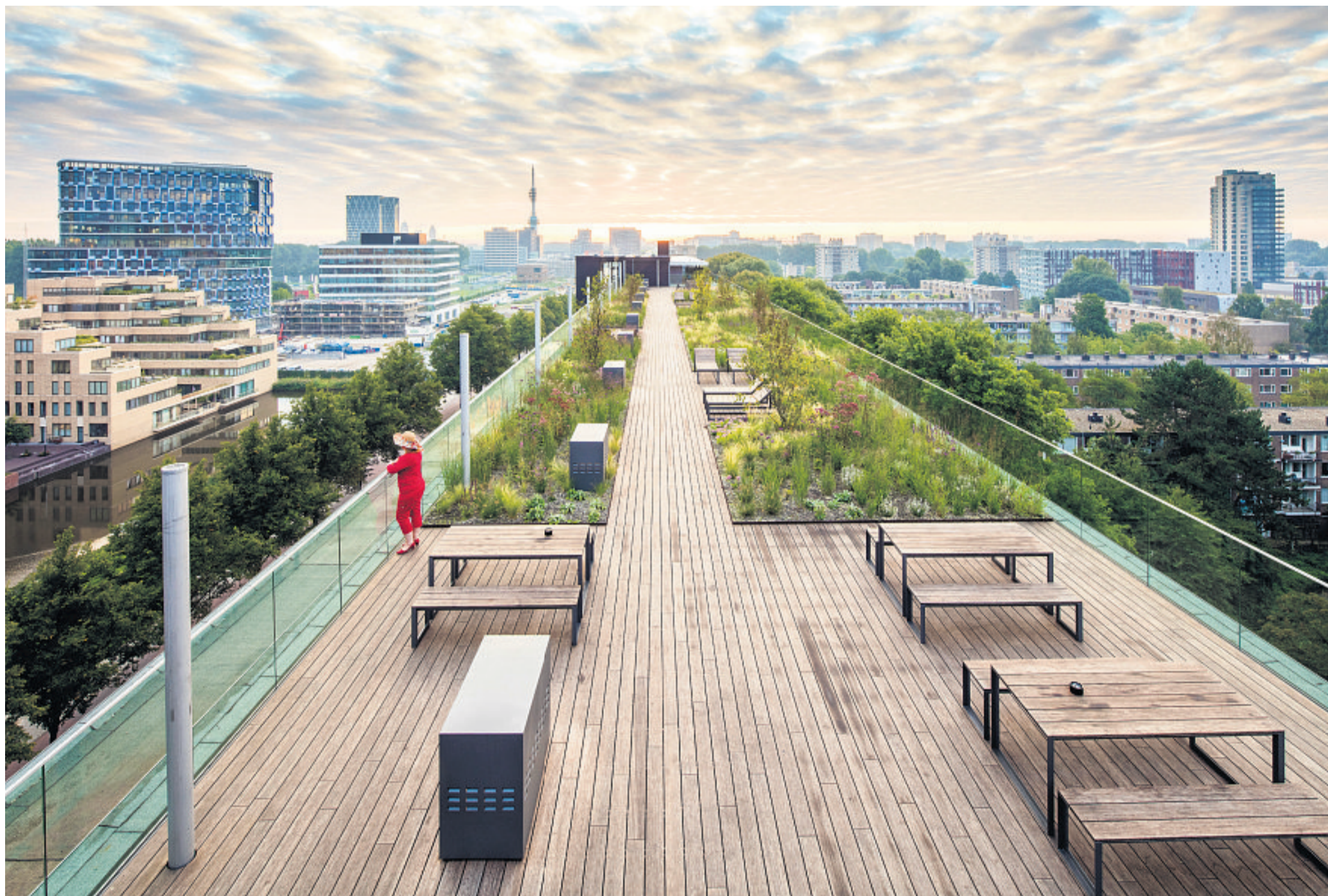
Het eerste Polderdak op de Amsterdams Zuidasdak. Regenwater kan door het systeem naar believen worden vastgehouden of afgevoerd. Zo wordt de wateroverlast beperkt.
